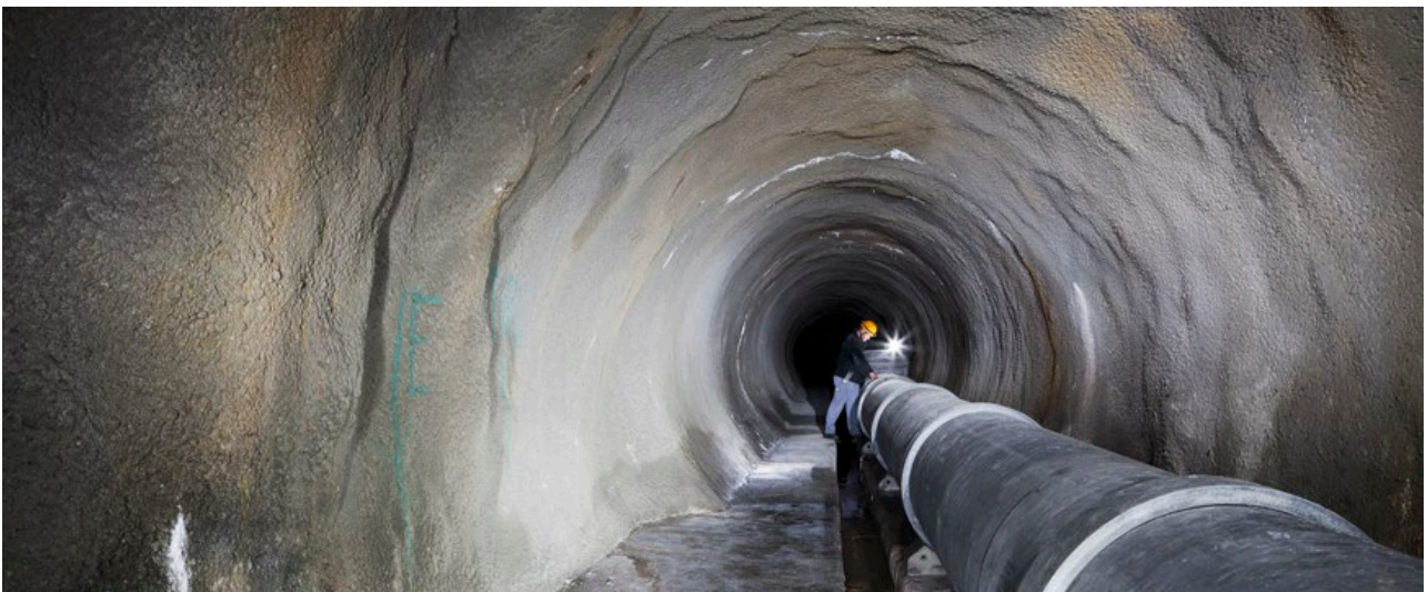
Rigi-Stollen mit Abwasserleitung
