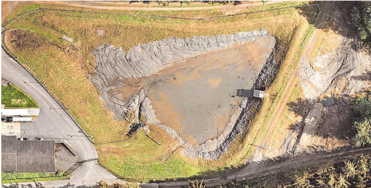
DER TEICH AUS DER VOGELPERSPEKTIVE: DER RECHTSSEITIGE DAMM STAND AM 15. JULI NACH DAUER- UND STARKREGEN VOR DEM BRUCH. FOTO: KREIS OLPE
