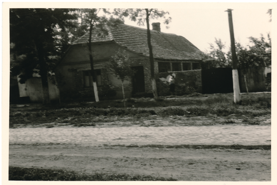
Haus Stuprich in der „Saugasse“ in Hatzfeld (1965) (Archiv: Walter Stupperich)
