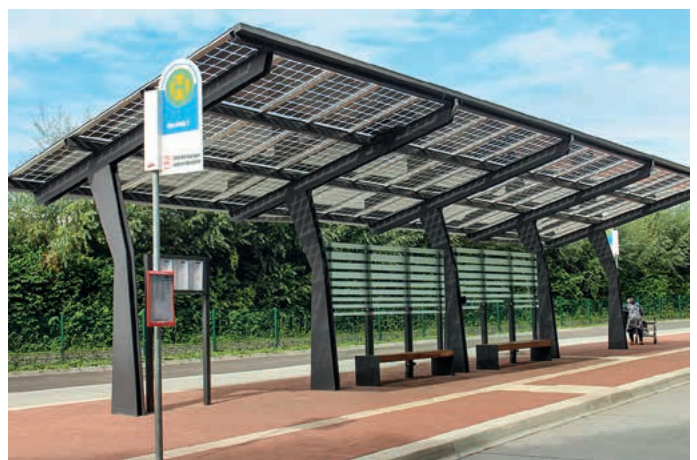
Der ZOB nach seiner Fertigstellung
