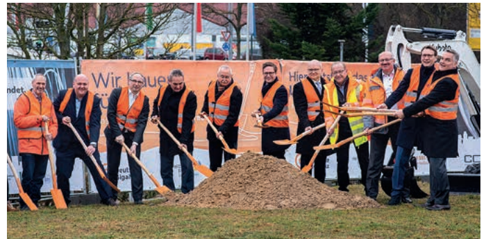
Symbolischer Spatenstich in Brackenheim mit Vertretern der Stadt, des Landkreises, aus dem Bundestag und der beteiligten Unternehmen.
