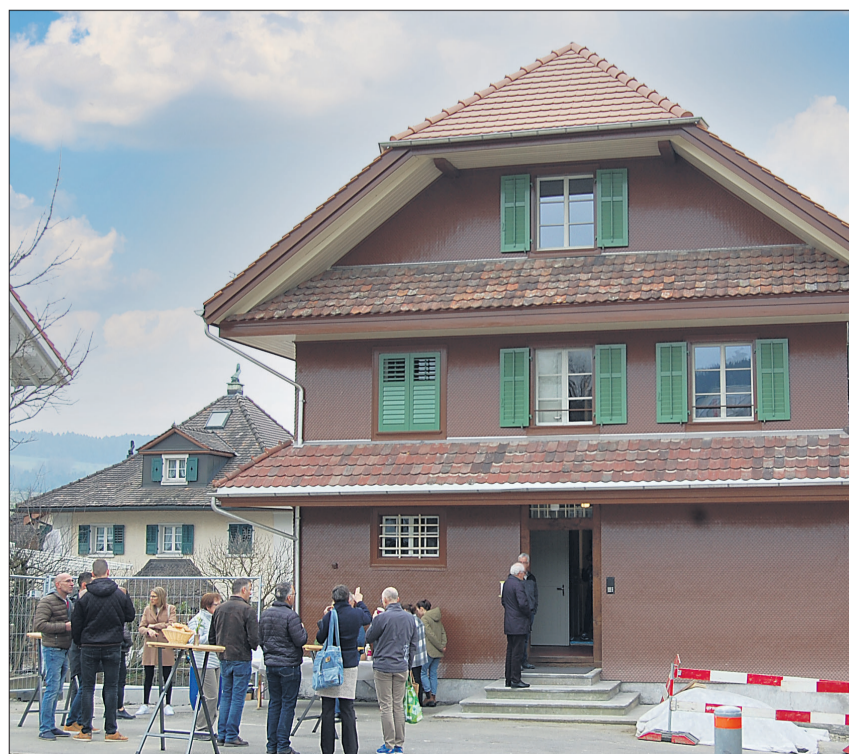
Das Lehrerheim wurde komplett im äusseren und inneren Bereich saniert. Fotos Willi Rölli
