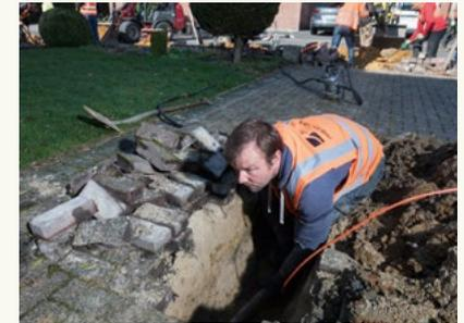
**4** Das Kopfloch wird provisorisch verschlossen, da es zur Aktivierung des Glasfaser-Anschlusses wieder geöffnet werden muss.
