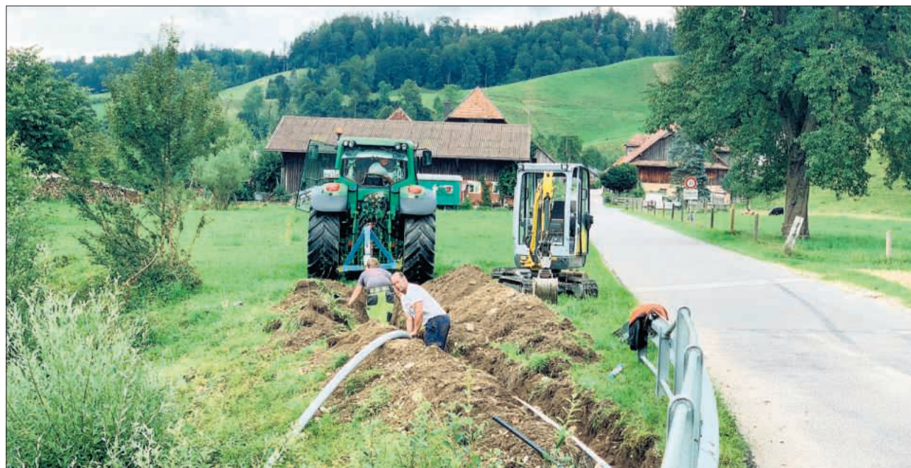
In der Pilotgemeinde Luthern ist das neue Glasfasernetz bereits zu 95 Prozent unter Boden verlegt. [Bild zVg]
