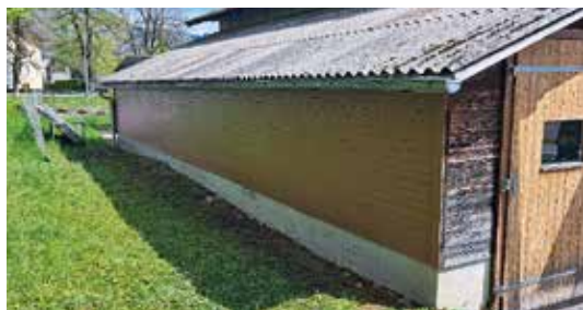
Die neugestrichene Fassade bei der Entsorgungsstelle
