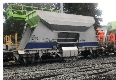
Einschottern der Gleise
