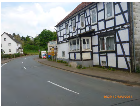
Blick in die Straße Fischtor (jenseits des Stadttors)
