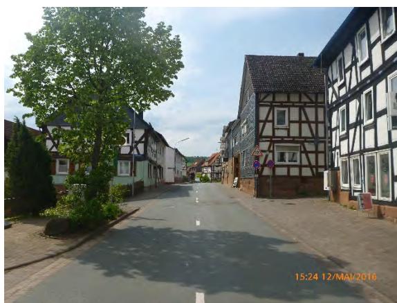
Blick in die Straße Obertor
