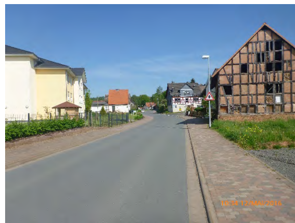
Willershäuser Straße Abzweig Breslauer Straße
