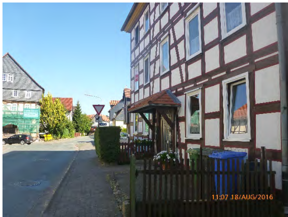
Marburger Straße Blickrichtung Straße „Fischtor“
