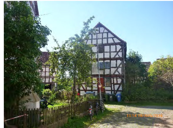
Wohngebäude Straße Im Sack, im Hintergrund die ehem. Hofraithe
