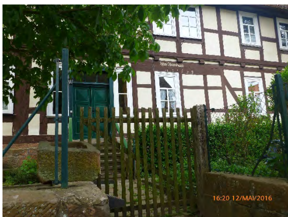
Wohnhaus Zehntstraße 12 (Amtshaus), Gelände ehem. Burg
