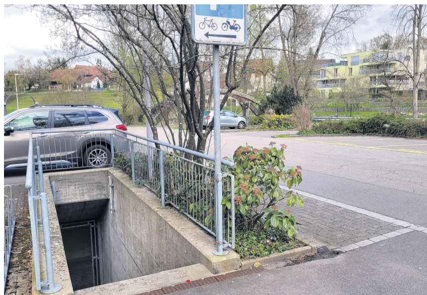
Der Kanton eröffnet in Dottikon eine weitere unterirdische Unterkunft. Container vor dem Eingang sollen für den oberirdischen Aufenthalt sorgen.
